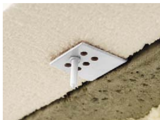
Montaż na powierzchniach poziomych (np. na suficie czy płycie balkonowej)
